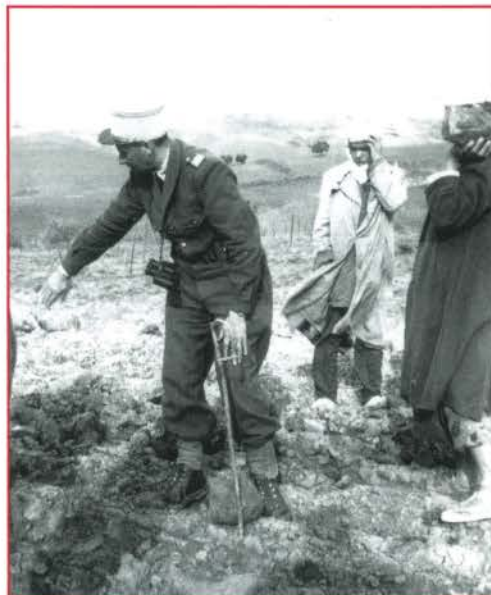
SAS d'Hanoteau : un chantier de route au douar Beni Derdjine
